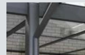
Tebau Flex in Dachfarbe beschichtetes Aluminiumfallrohr
