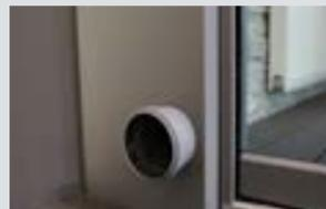
Tebau Linea mit in die Stützen integriertem Fallrohr.
